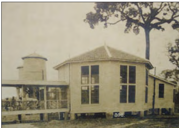
Parte da estrutura do Hospital da Candelária
