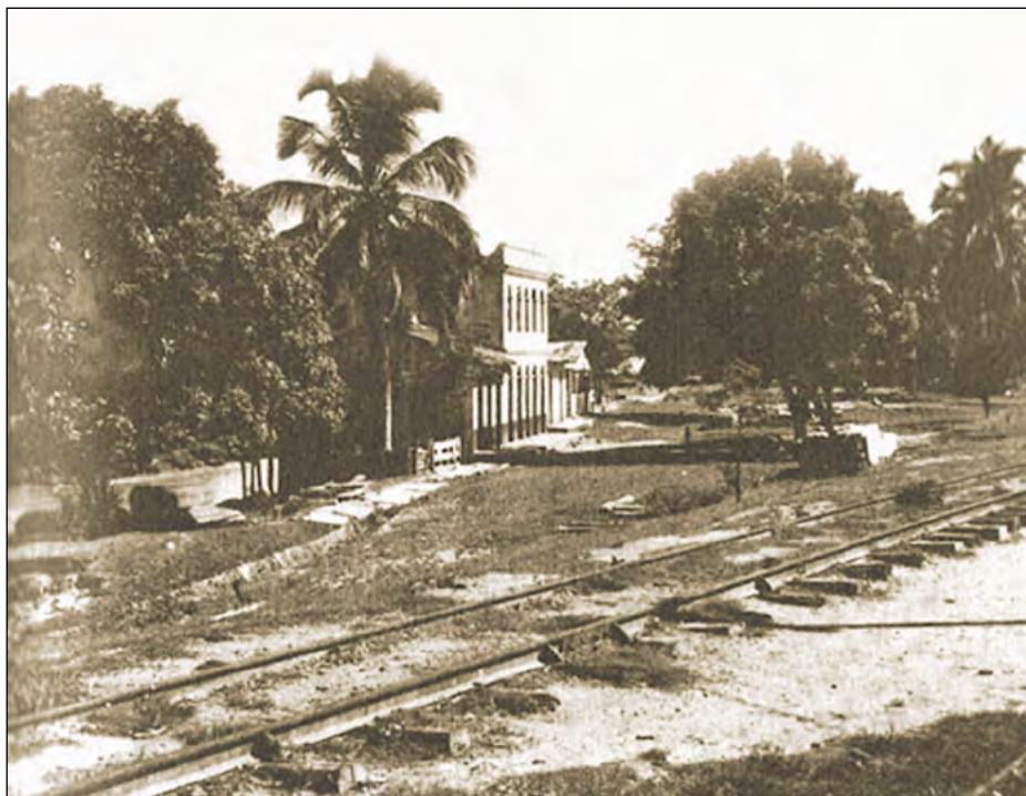
Sobrado de Santo Antônio do Rio Madeira
