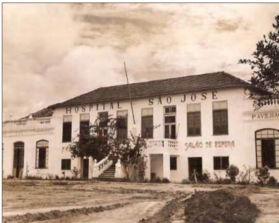
Parte da fachada original do Hospital São José
